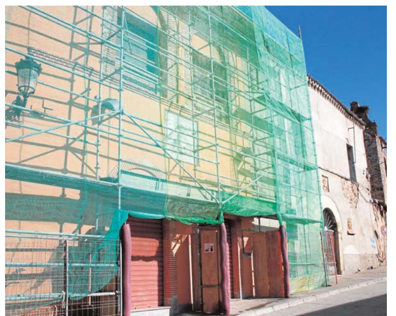
Los andamios recubren el Teatro y el Hospital para arreglar el tejado. | EÑE
